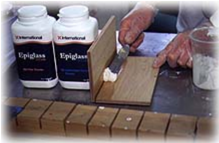
Dem Harz soviel Füller zugeben, daß eine modellierfähige Spachtelmasse entsteht.
