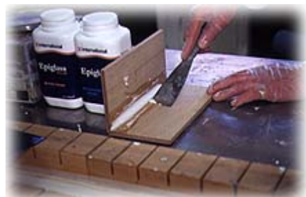
Überschüssige Spachtelmasse vor dem Aushärten mit Metallschaber entfernen.
