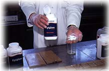
Angeschliffene Untergründe vor dem Kleben mit Epoxidmischung versiegeln.
