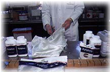
Das Glasfasergewebe größer ausschneiden als die zu verstärkende Fläche.
