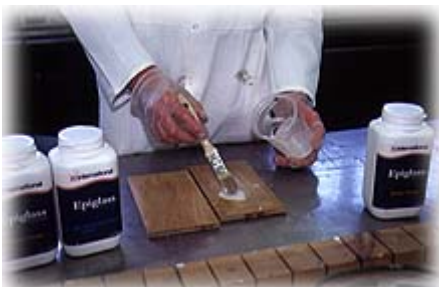
Masse auf die Klebeflächen geben. Materialdifferenzen werden ausgeglichen.
