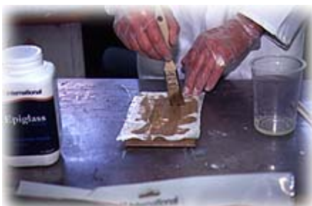
Glasfasergewebe gut harzgetränkt auflegen und mit Pinsel oder Rolle andrücken.
